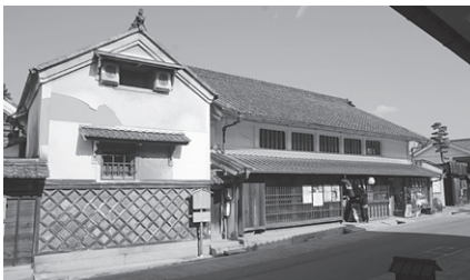
旧東海道に面した外観 : 表土蔵と主屋
