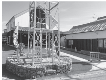
石積みで囲われた脚部
