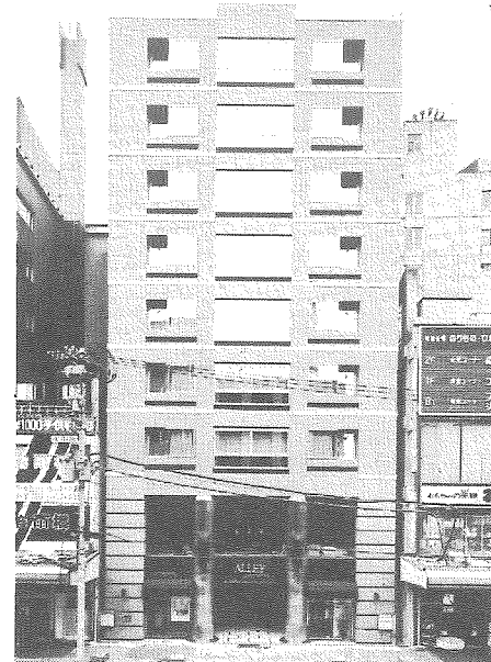
片町ALLEYビル
