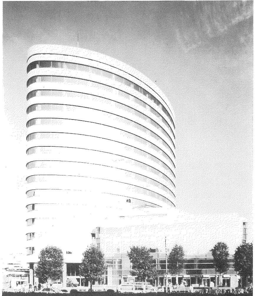
JBPオーバルの外観
