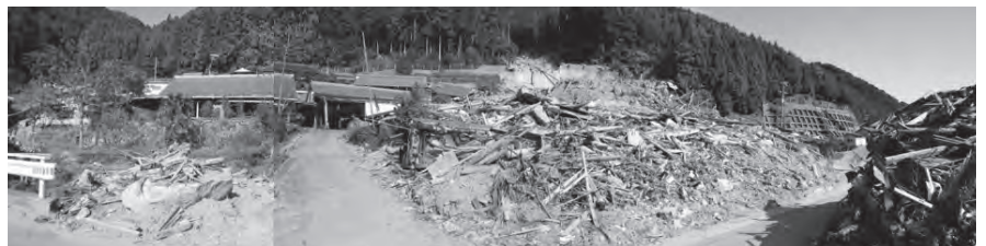
写真 浅里地区の被害状況(紀伊半島大水害:2011年)
