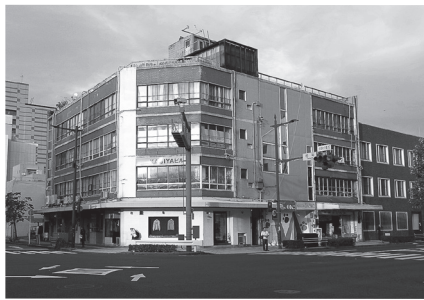
浜松 田町防災建築街区 カギヤビル 403architecture [dajiba]が複数のリノベーションを手がけたことで知られる
