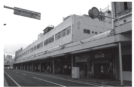
富士 吉原本町防災建築街区 本一ビル 近現代建造物の詳細調査対象となった。近隣では富士山まちづくり株式会社、勝亦・丸山建築事務所、伊達剛建築設計事務所などがリノベーションに取り組んでいる
