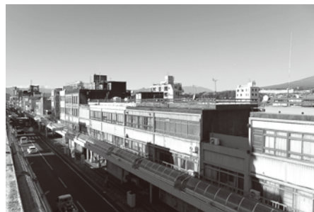
富士 吉原本町防災建築街区 旧東海道沿いの両側に壁面線の揃ったビル
