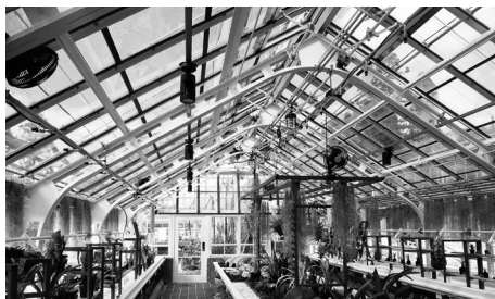
後館鉄骨(撮影:2022年3月3日)
