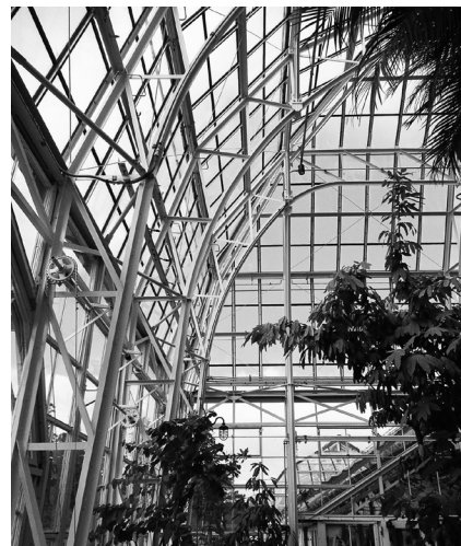
前館鉄骨(撮影:2022年3月3日)
