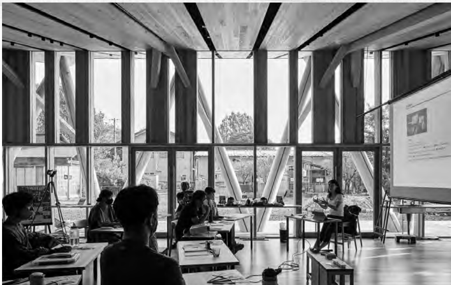
耐震性能を高め、屋外に開かれた開放的な室内空間。外部に丸太のトラス架構が見える。
