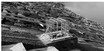
東堤の枋跡にある現在の枋(水門)
