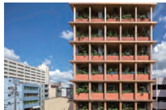
GOOD CYCLE BUILDING 001 浅沼組名古屋支店改修 PJ
