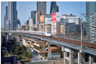
笹島高架下オフィス
