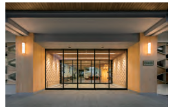
尾鷲市役所本庁舎耐震改修
