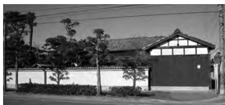
南側外観(右:長屋門倉庫妻面、中奥:主屋)
