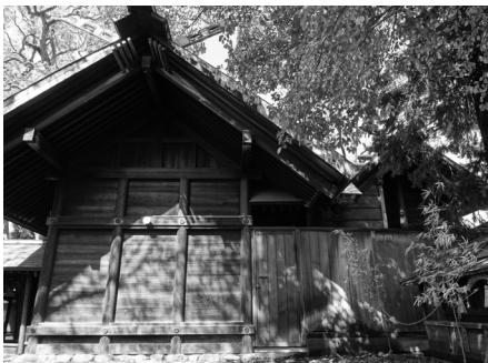
本殿・拝殿側面
