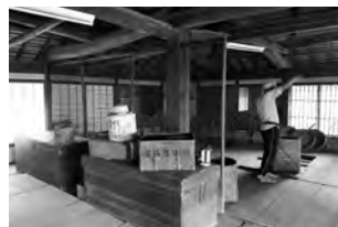
▲2階板の間 荷揚げ用の開口部が床に設けられている
