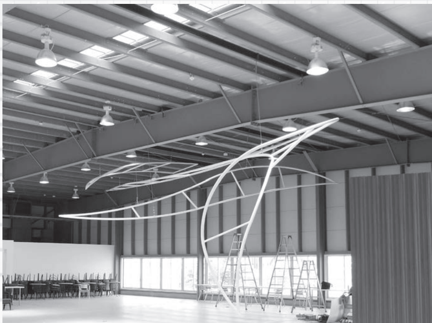
(図2) 支持点のみで吊られた状態の単管パイプの形状
