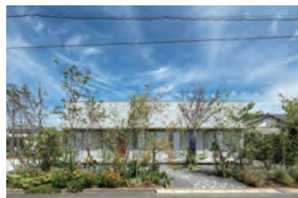
空蟬の家 ①静岡県浜松市 ②鉄筋コンクリート造 地上1階 111.79㎡ ④KARMAN STUDIO ⑤エヌテックサービス
