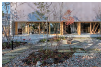
建築設計事務所が運営する小さな複合施設 [h+BASE] ①福岡県福岡市 ②木造 地上2階 360.75㎡ ③hplus ④h+ARCHITECTS ⑤深谷
