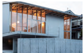
福井の住宅 ①福井県福井市 ②木造一部鉄筋コンクリート造 地上2階地下1階 171.23㎡ ③水上智也建築設計事務所一級建築士事務所 ⑤水上建設
