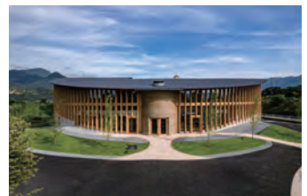
OYAKI FARM BY IROHADO ①長野県長野市 ②木造在来工法 地上2階 1,733.64㎡ ③いろは堂 ④遠野未来建築事務所 ⑤寺島工務店
