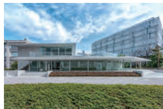
名古屋大学オクマ工作機械工学館 ①愛知県名古屋市 ②鉄骨造鉄筋コンクリート造 地上2階 地下1階 1,485.61㎡ ③国立大学法人東海国立大学機構 ④国立大学法人東海国立大学機構施設統括部 諸江一紀建築設計事務所 D.L.G Architects 佐々木勝敏建築設計事務所 名古屋大学工学部施設整備推進室 東畑建築事務所名古屋オフィス ⑤松井建設名古屋支店
