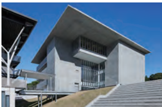
静岡理工科大学土木工学科棟 あーすつりー ①静岡県静岡市 ②鉄筋コンクリート造一部鉄骨造 地上4階 3,782.62㎡ ③学校法人静岡理工科大学 ④栗生明・北川・上田総合計画 小石川建築ノ小石川土木 ⑤鈴与建設
