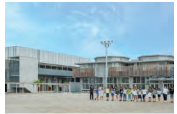
岐阜市立長良小学校および長良公民館 ①岐阜県岐阜市 ②鉄筋コンクリート造一部鉄骨造 地上2階 9,544.84㎡ ③岐阜市 ④大建・大建met設計共同体 ⑤市川・福屋・土本特定建設工事共同企業体
