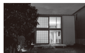
スミレアオイハウス 外観夕景
