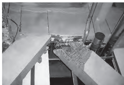
写真-4 新耐震設計の建物被害、左上から：壁のずれ(打継ぎ面の施工不良?)、中：柱と梁の接合損傷(梁上フランジ破断によるヒンジ)、1階の筋交の破壊、などは大地震での基準法どおりの被害である。
