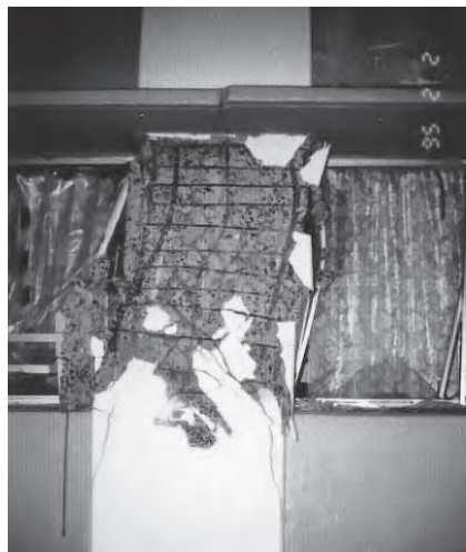
写真-4 新耐震設計の建物被害、左上から：壁のずれ(打継ぎ面の施工不良?)、中：柱と梁の接合損傷(梁上フランジ破断によるヒンジ)、1階の筋交の破壊、などは大地震での基準法どおりの被害である。
