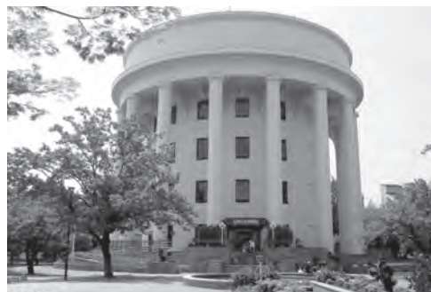
名古屋市演劇練習館「アクテノン」（旧稲葉地配水塔、旧中村図書館）
