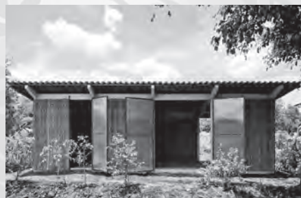
⑦「TS House 2」(ヴォ・チョン・ギア+岩元真明+西島光輔/VTNアーキテクト、2014年竣工)。大木宏之撮影、VTNアーキテクト提供
