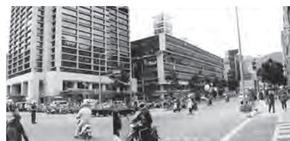
写真-3 神戸市庁舎は旧耐震基準による鉄筋コンクリート8階建(地下1階)、その6階が層崩壊したが、新館は鉄骨造の超高層ビルは無被害であった。(設計は大臣特認による高度な設計)
