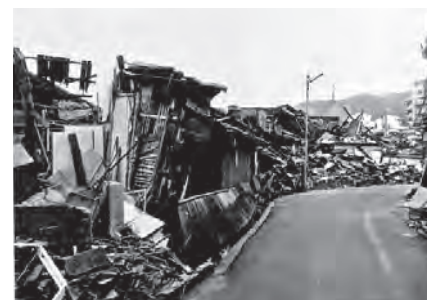
写真-1 東灘区の木造住宅の倒壊
