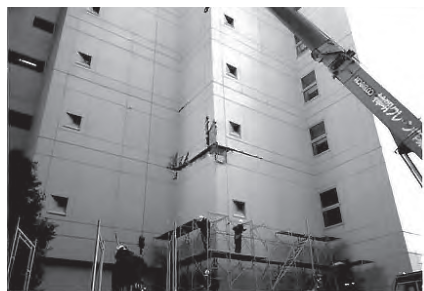
写真-5 新耐震設計による深江にある高層RC市営住宅は柱のせん断損傷、建物の倒壊はないことから耐震規定による耐震性はあったことになる。しかし補修には時間と補修費がかかる。分譲マンションだとすると、住人は耐震住宅と理解できるだろうか。
