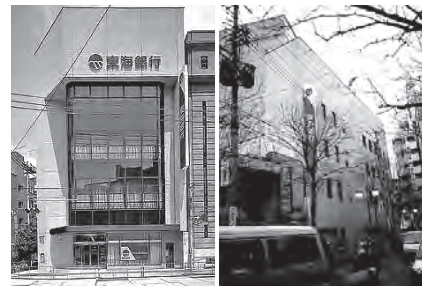
写真-7 無被害のSRC4階建て三宮駅前の銀行支店、しかし、室内の家具は散乱していた。(SRCとしたのは平面が不整形で柱間が大きいことによる)
