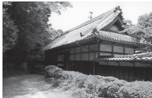
外側から見た長屋門
