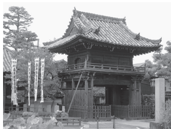
近く解体修理の行われる予定の山門
