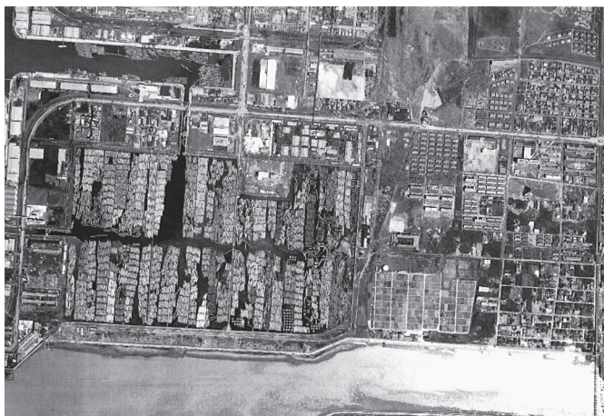
写真3 天白川に建てられていた送電線鉄塔を取り込んで、高潮堤防を築き貯木場を再開した（貯木場の丸太がたくさんある）
