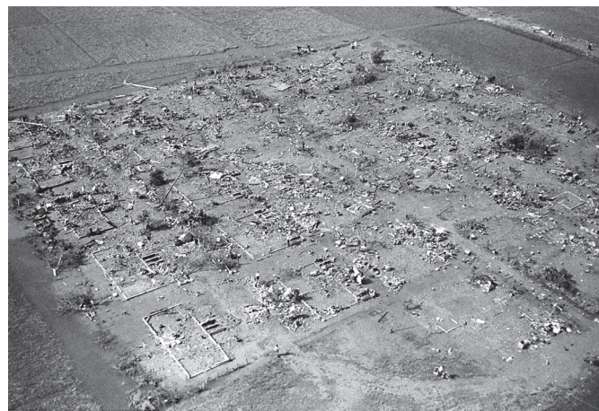
写真4 堤防決壊による全壊建物の基礎（半田市康衛町、現在は瑞穂町と町名を変えた）
