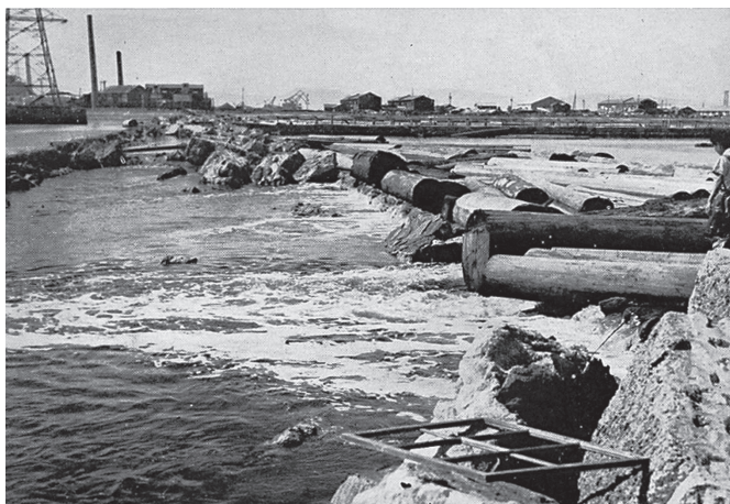
写真1 堤防が破壊され、潮の干満が激しい決壊口：中日新聞社
