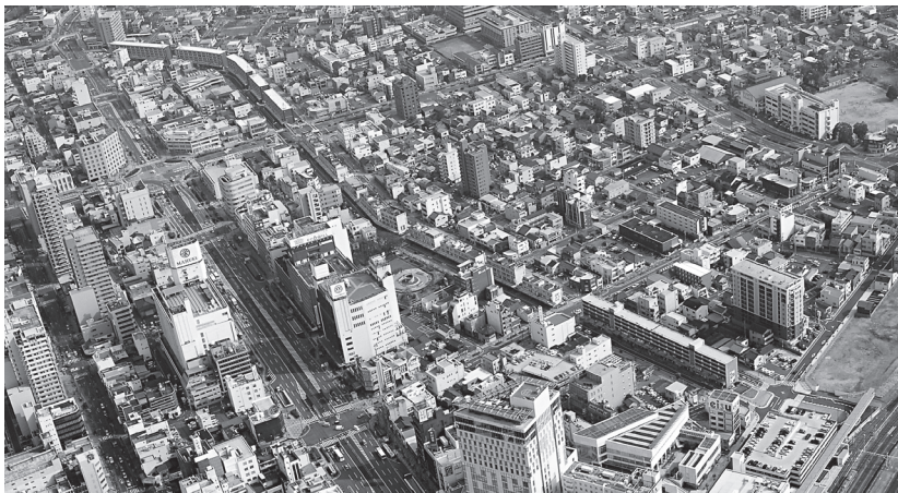
「水上ビル」空撮。写真右下の駅前から、豊橋ビル、大豊ビル、大手ビルが800mにわたって連なる
