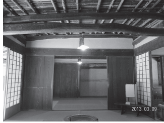
佐吉生家の内部。土間から「おおえ」「おでい」を見る
