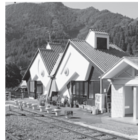
飯田線愛知県境の東栄駅舎全景
