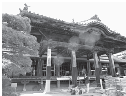
善光寺大勧進万善堂 左：解体前 右：屋根フレームの解体
