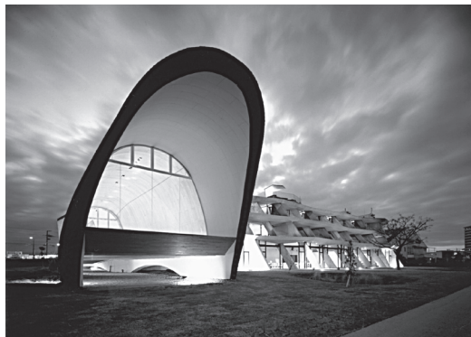
琵琶湖のエコトンホテル／風の音 ヤンマーマリーナホテル セトレマリーナびわ湖 ①滋賀県守山市 ②セイレイ興産株式会社 ③芦澤竜一建築設計事務所 ④戸田建設株式会社 ⑤RC造 一部木造 地上3階 ⑥2,800.09㎡
