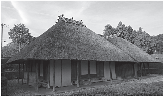
南より主屋、釜屋を見る
