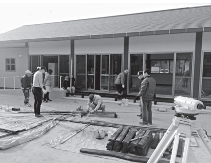
ワークショップにて駐車場にタイルを舗設したり(左)、濡れ縁製作に取り組んだ(右)
