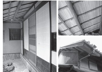
左・上 | 割竹の化粧軒裏・巾木換気口 下 | 延焼防止外壁軒裏 (現在鉄板で覆う)
