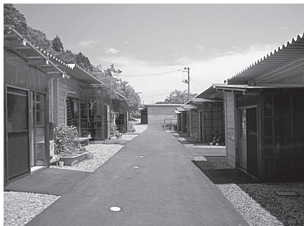
玄関が向かい合わせの仮設住宅 (2012年撮影)
