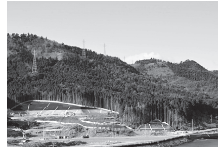
谷川浜の高台造成工事
