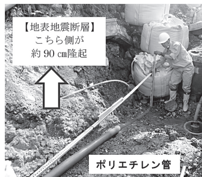
写真2: 地表地震断層を横過するポリエチレン管の掘削調査
