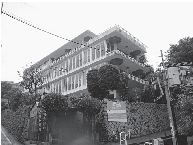
坂倉準三が設計したアンスティチュ・フランセ東京(旧東京日仏学院)の外観(筆者撮影)
