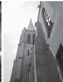
尖塔と東側側面のバットレスと吐水樋
