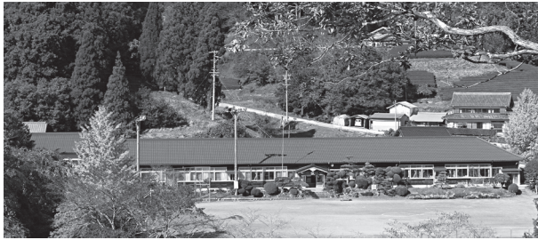
田峯小学校南面全景
