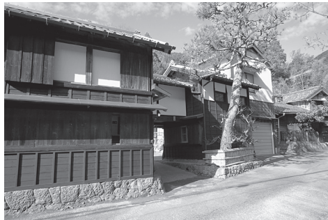
街道沿いの建物のひとつで、二階部分を廊下でつなぎ、その下から奥の庭へと通じている。かつては集落周辺の傾斜地一面蜜柑畑だったほど蜜柑栽培が盛んで、農作業や貯蔵のための付属屋を狭い谷あいには建てるため、街道ぎりぎりまで敷地を利用した工夫が感じられる
