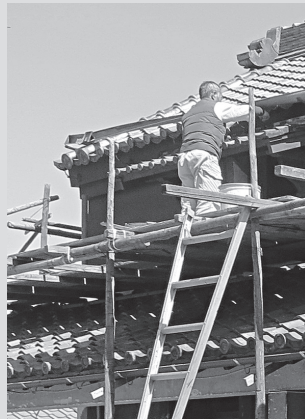
図4 | 修理可能なことは、時間で計る上で重要なポイント
