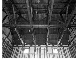
キングポストトラスの小屋組み
