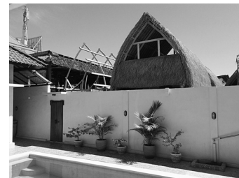
建築中の藁葺き屋根
