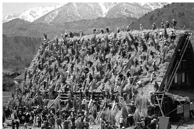
30～50年毎の葺替え集落中が協力して役割を分担して行われ、「結」と言われる。結は屋根葺替の他、田植えなど共同や扶助が必要なさまざまな暮らしの場面で機能している
