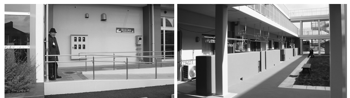
多賀城市の桜木地区災害公営住宅です。海が見えない土地で、人の高さまで津波が来ました。共用の屋外通路からアルコブを通過して住戸は2階から上にあります。「みんなのリビング」という部屋がありましたが、使い方はまだ話し合っているそうです。「みんなのもの」は「だれのものでもない」と思います
